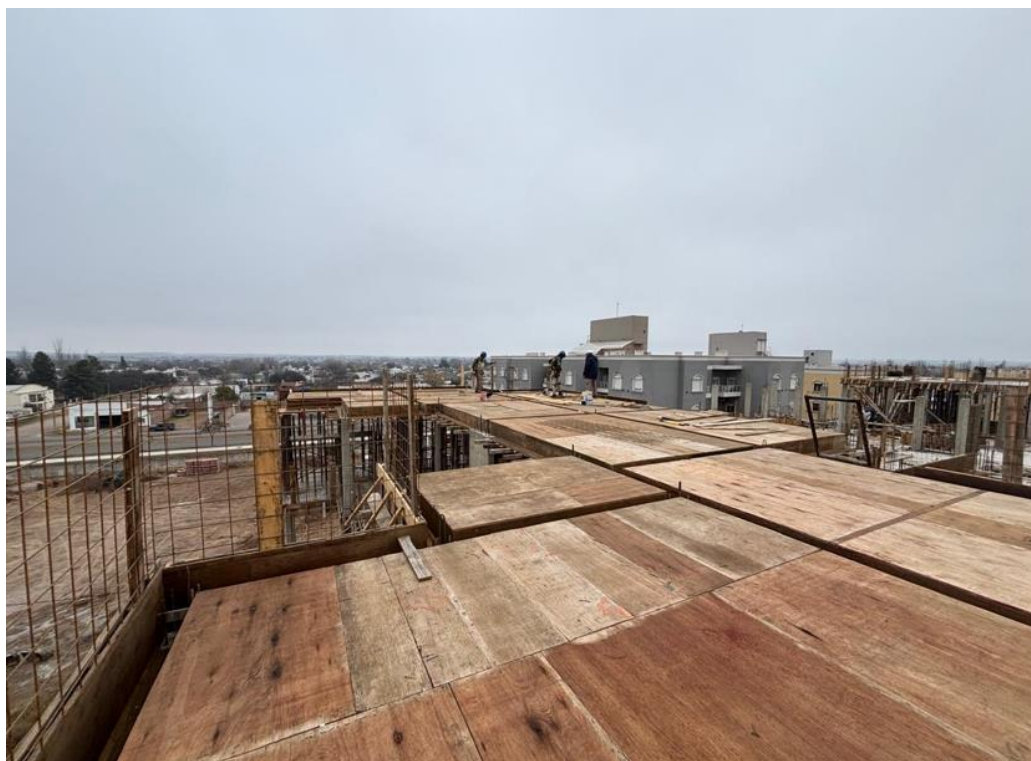
Vista. LOSA SECTOR C – TERRAZA. Preparado de encofrados.
