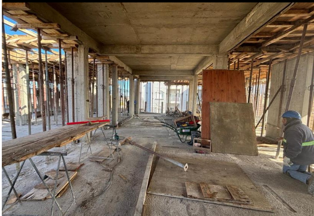
Vista. LOSA SECTOR A – TERRAZA. Desencofrados.
