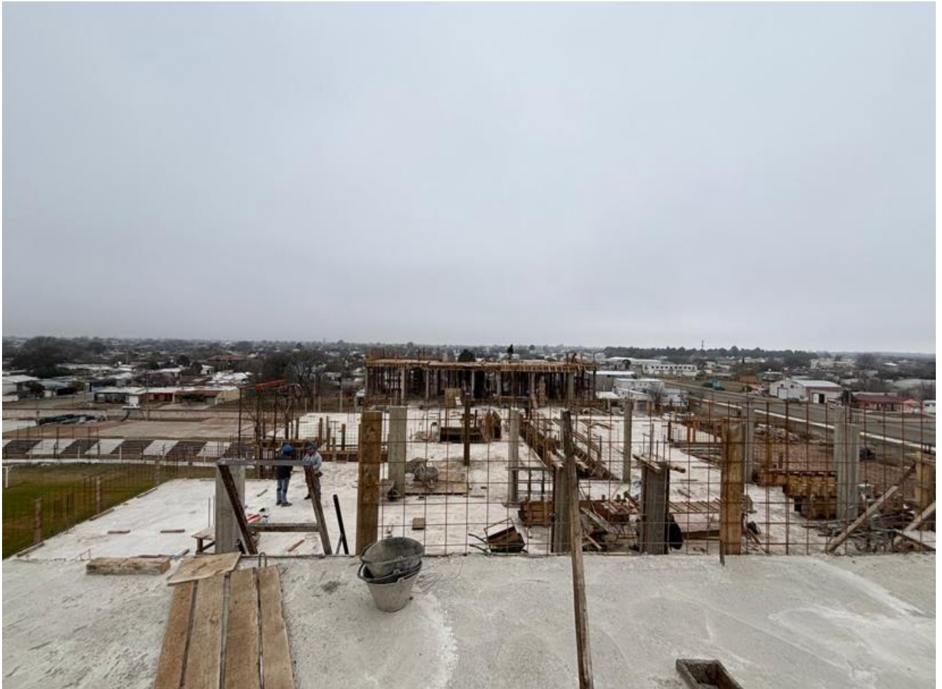
Vista. SECTOR DE TRABAJO EN TERRAZA.
