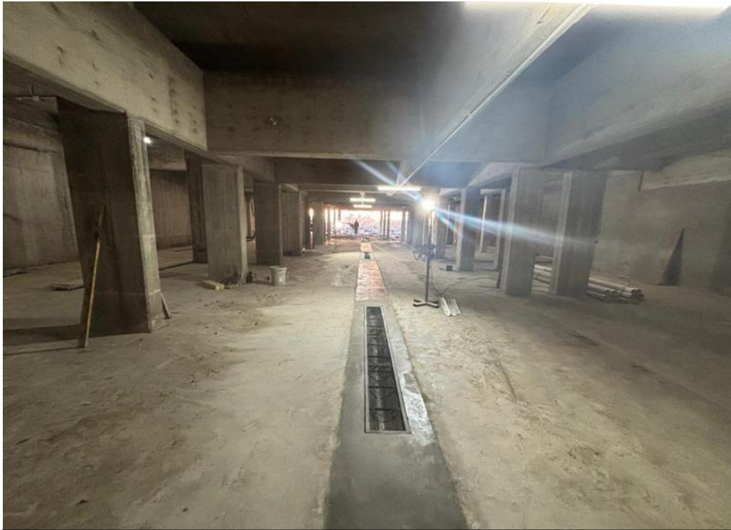
Tarea Piso de Hormigón – TORRE 7
